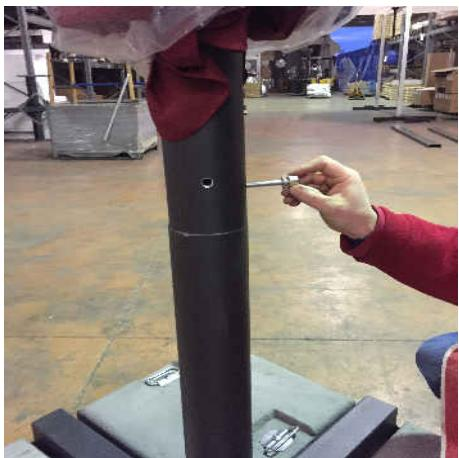
I. Ruotare il palo dell'ombrellone fino a far coincidere i 4 fori del palo con i fori del tubo e inserire le due viti; fissare bene i dadi alle estremità. Tutta la viteria è fornita con l'ombrellone.
